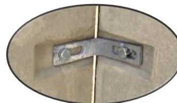
Detail 1 Eckverbindung
