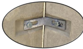
Detail 1 Eckverbindung
