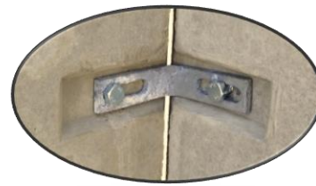
Detail 1 Eckverbindung
