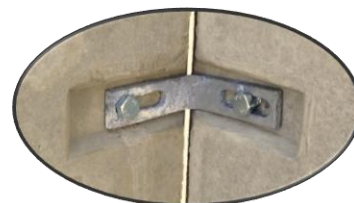
Detail 1 Eckverbindung
