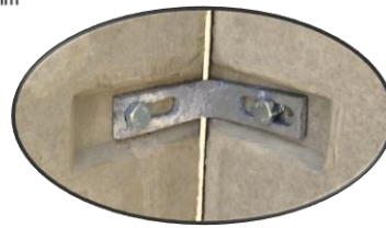
Detail 1 Eckverbindung
