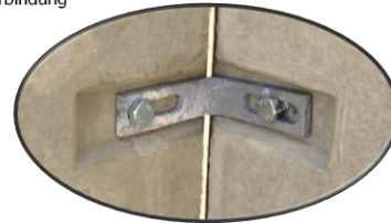
Detail 1 Eckverbindung
