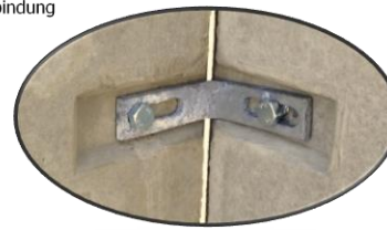
Detail 1 Eckverbindung
