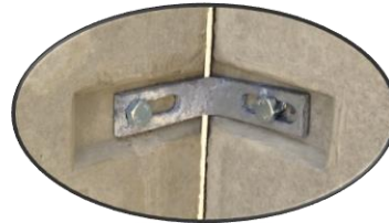
Detail 1 Eckverbindung
