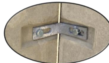
Detail 1 Eckverbindung
