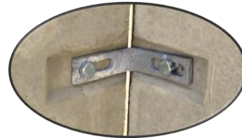
Detail 1 Eckverbindung
