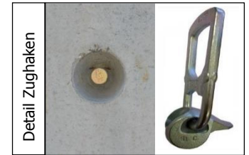
Detail 1 Eckverbindung
