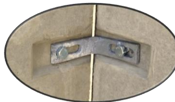
Detail 1 Eckverbindung
