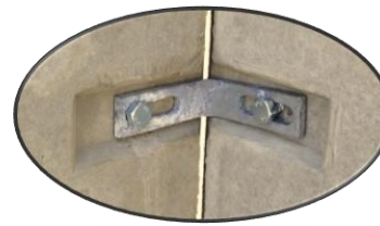
Detail 1 Eckverbindung
