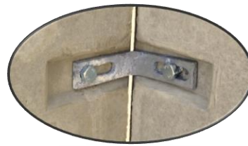
Detail 1 Eckverbindung
