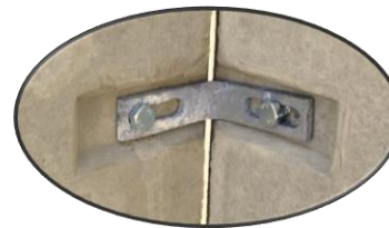
Detail 1 Eckverbindung
