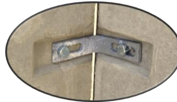
Detail 1 Eckverbindung
