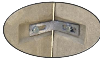
Detail 1 Eckverbindung
