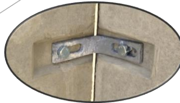
Detail 1 Eckverbindung
