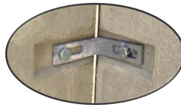
Detail 1 Eckverbindung
