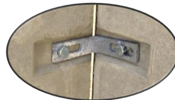
Detail 1 Eckverbindung
