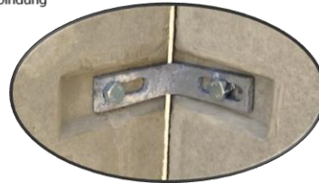
Detail 1 Eckverbindung
