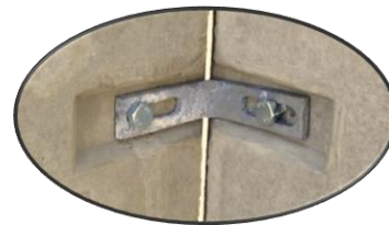
Detail 1 Eckverbindung
