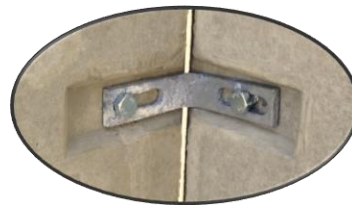
Detail 1 Eckverbindung
