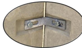
Detail 1 Eckverbindung
