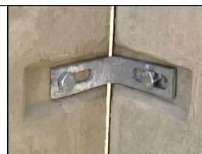
Détail 1. Joint d'angle
